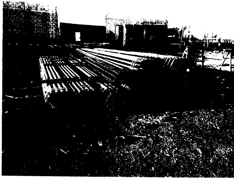
FOTO 07: Vista panorámica de la obra
